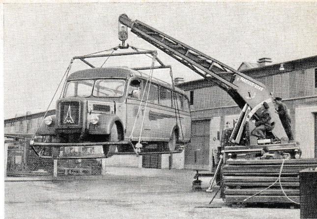
Bild 15: Heben und Schwenken eines 5 1/2-t schweren Omnibusses um 180° (großes Benutzungsfeld).
